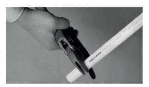
После предварительного осмотра в случае необходимости трубу нужно отрезать при помощи специальных режущих приборов (ножницы или труборез, в зависимости от диаметра) строго под углом 90  $^{\circ}$ , образовавшиеся заусенцы и стружку нужно удалить. При помощи маркера рекомендуется обозначить глубину сварки на конце трубы. При этом нужно учитывать, что труба не должна быть вставлена до упора в муфту фитинга с целью предотвращения сужения проходного сечения в месте соединения (не более 1 мм).
